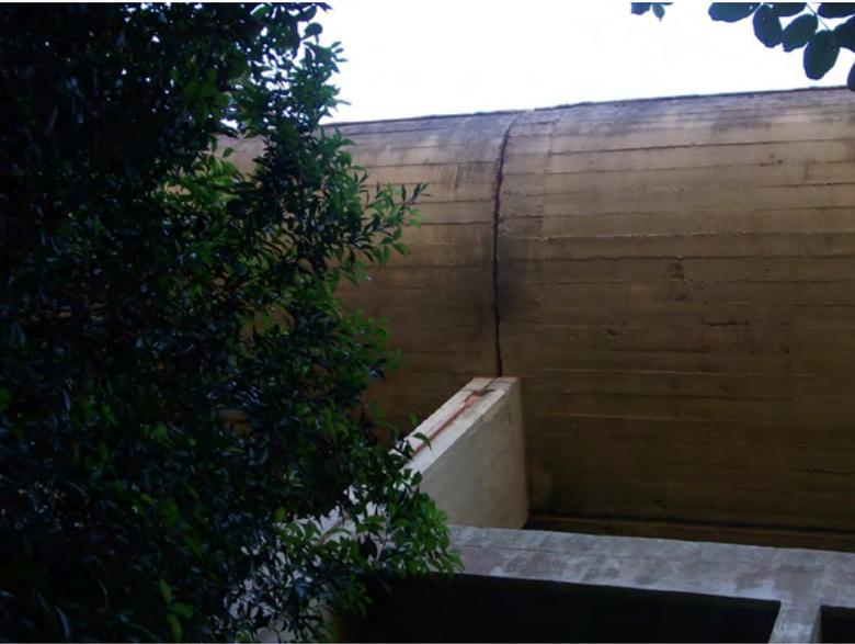
Imagen 11. Fotografía del autor que muestra la junta de dilatación producida modularmente cada tres aulas.
